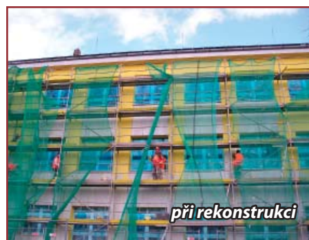
při rekonstrukci - pohled zadní
