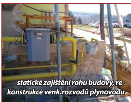
statické zajištění rohu budovy
